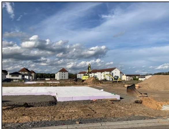
Abb. 9: Blick auf das zentrale Plangebiet im Bereich der Ein- und Mehrfamilienhäuser.
