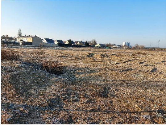
Baugebiet Boßwenhain, von der Frankfurter Straße her
