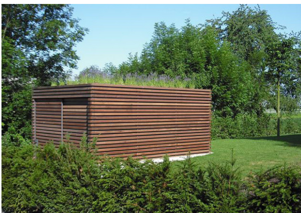
Gartenhaus mit begrüntem Dach
