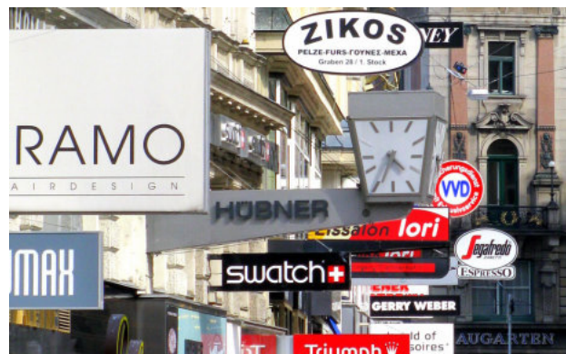
Unkontrollierte Anordnung von Werbeanlagen an Gebäudefassade
