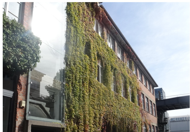
Fassadenbegrünung im gewerblichen Bestand
