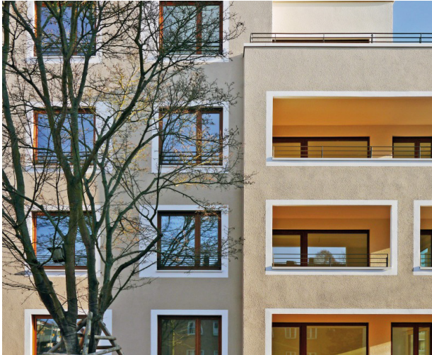
Gliederung Hausfassade, Würzburg
